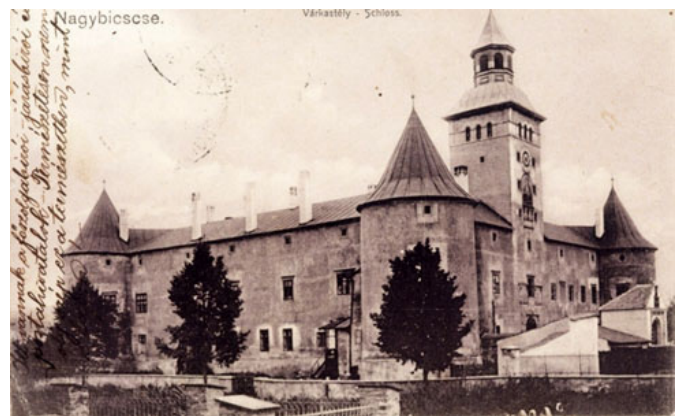
Turzovský zámok v Bytči (1907) – sídlo archívu
