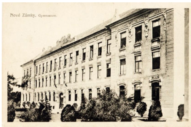
Budova Gymnázia v Nových Zámkoch (1946)
