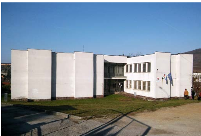
Archívne pracovisko vo Veľkom Krtíši vo vlastnom objekte sídli od roku 1969, kvôli nedostatočnej kapacite depotov má časť archívnych fondov umiestnenú v prenajatých priestoroch. Foto: Igor Graus.
