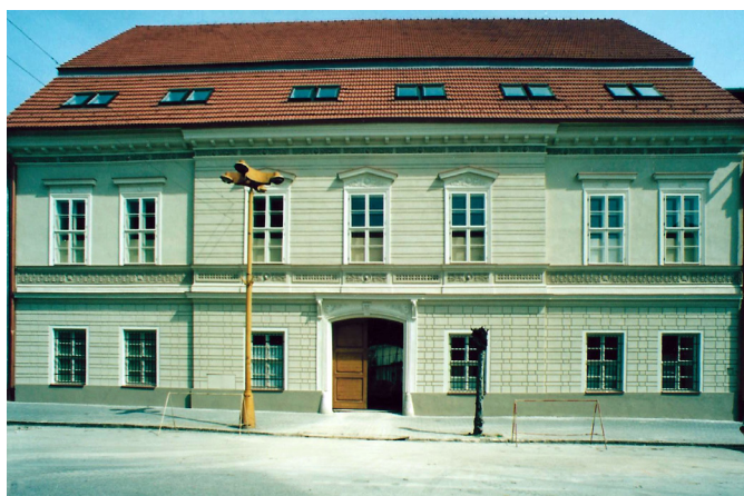
Priečelie archívu po rekonštrukcii. Zdroj: MVSR, Štátny archív v Trnave.
