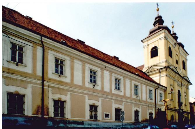
Budova jezuitského kláštora na Štefánikovej ulici v roku 2002. Zdroj: MVSR, Štátny archív v Trnave.
