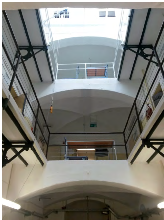
Pohľad z prízemnia depotu v Suhle smerom k presklenej streche. Po obvode nadzemných podlaží sa nachádzali kedysi celý väzňov, ktoré dnes slúžia na uchovávanie archívnych dokumentov. Foto: Jozef Meliš.
